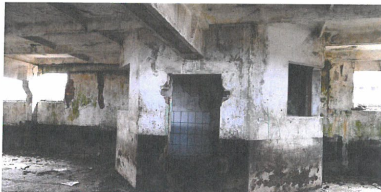
Foto nr. 22 – Pereți interiori și exteriori afectați de igrasie în corp C4
