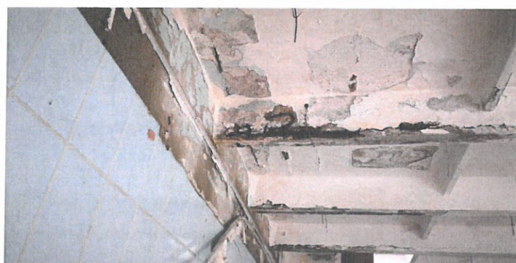
Foto nr. 30 – Chesoane de acoperiș degradate – Corp C10
