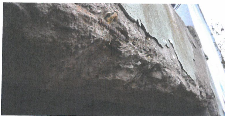
Foto nr. 20 – Beton și armături degradate la grindă din Corp C9
