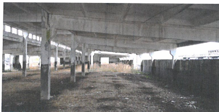
Foto nr. 14 – Aspect cadre prefabricate Corp 1
