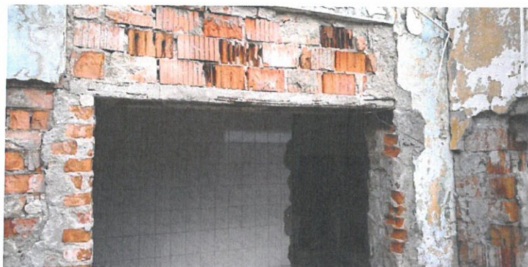
Foto nr. 26 – Perete exterior degradat - Corp C6
