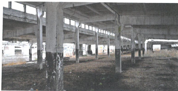
Foto nr. 16 – Aspect cadre prefabricate Corp 3
