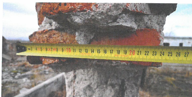
Foto nr. 24 – Perete din zidărie degradat – Corp C12
