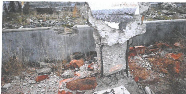
Foto nr. 25 – Stâlpișor din beton armat degradat – Corp C12
